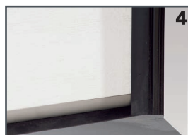
Bodenabschluss außen, in E6/EV1
