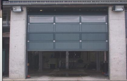
Bestehend aus einer Rahmen-Sprossen-Konstruktion
