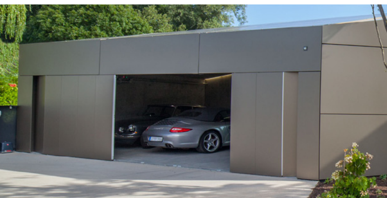
Privathaus Tübingen, Rahmen-Sprossen-Konstruktion mit Alucobond-Bepankung
