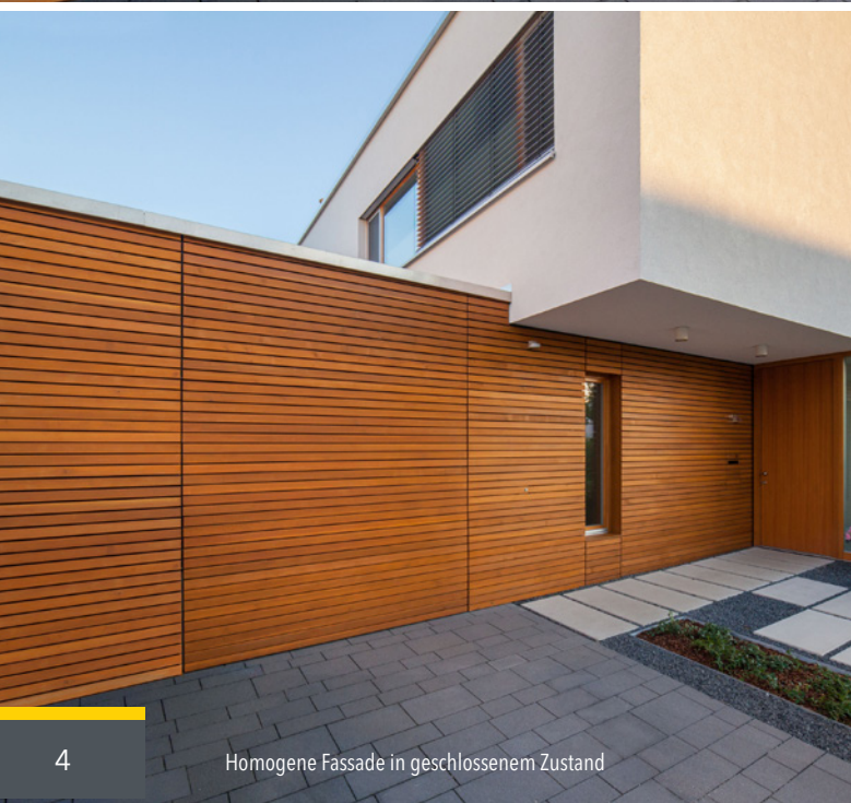
Unsichtbare Holzverkleidung ohne sichtbare Verschraubung der einzelnen Lamellen
