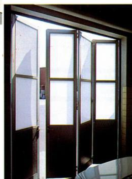
Rohrrahmen-Konstruktion mit geschlossenen und verglasten Füllungen
