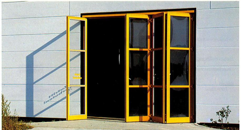
4flügeliges Faltschiebetor geöffnet, linker Flügel als Gehflügel.
