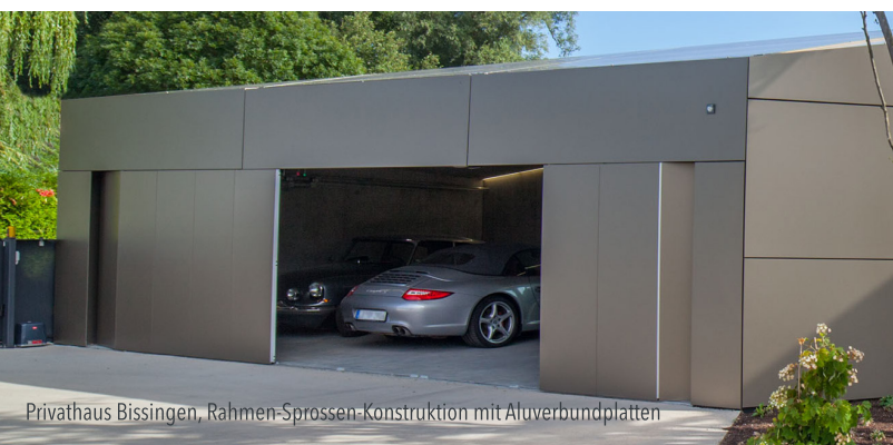
Aluminium-Rahmen-Sprossen-Konstruktion, Beplankung bauseits
